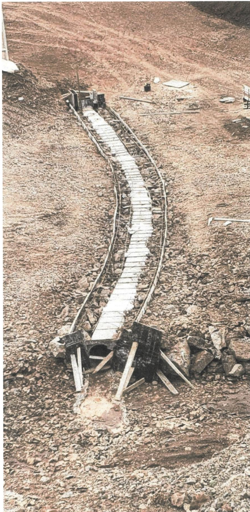
EXECUÇÃO DE TUBULAÇÃO NA GRANJA FARADAY - CAPANEMA
