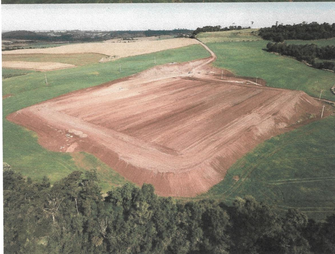
CANTEIRO DE OBRAS GRANJA FARADAY – CAPANEMA
