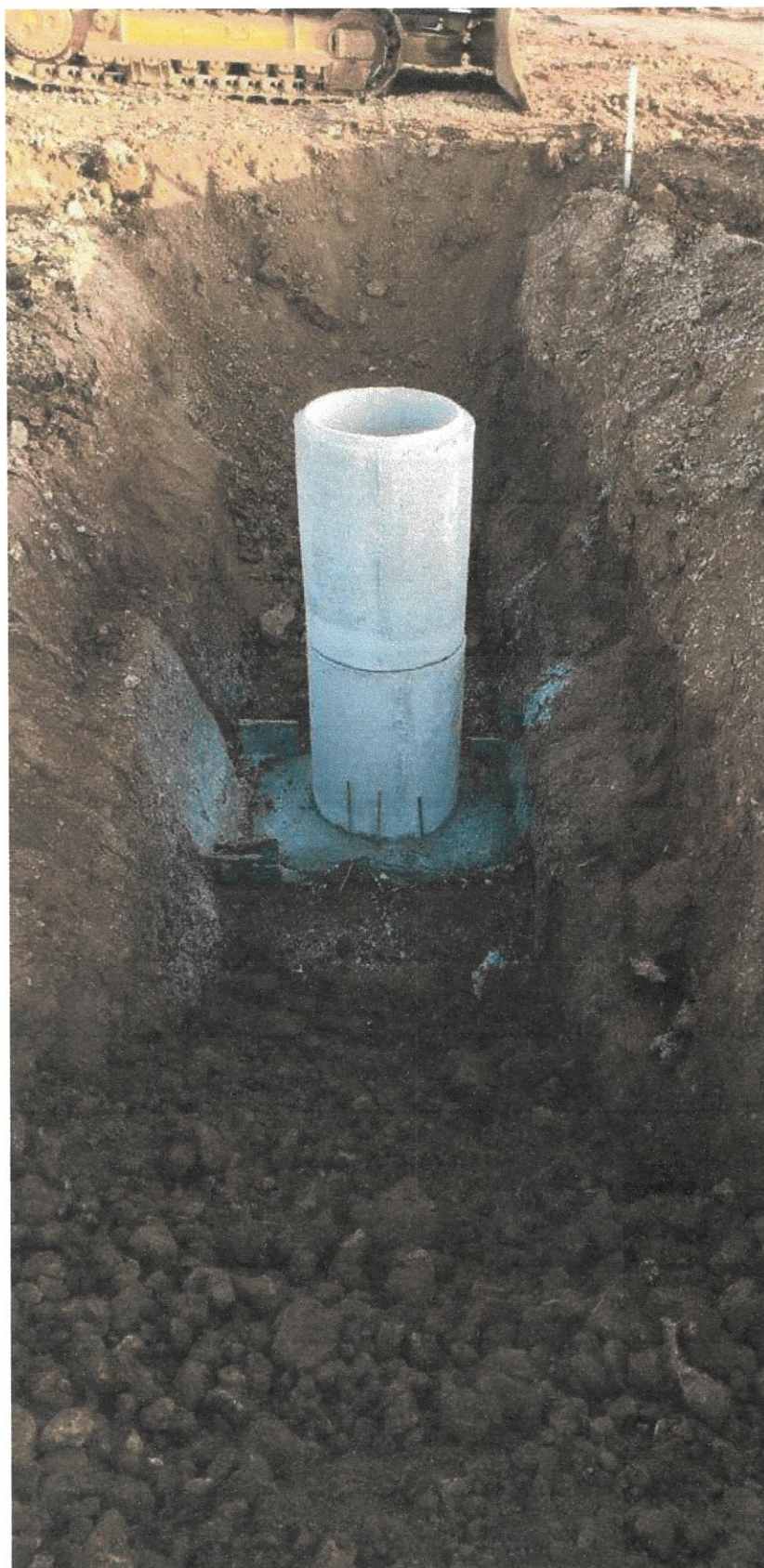
EXECUÇÃO DE TUBULAÇÃO NA GRANJA FARADAY - CAPANEMA
