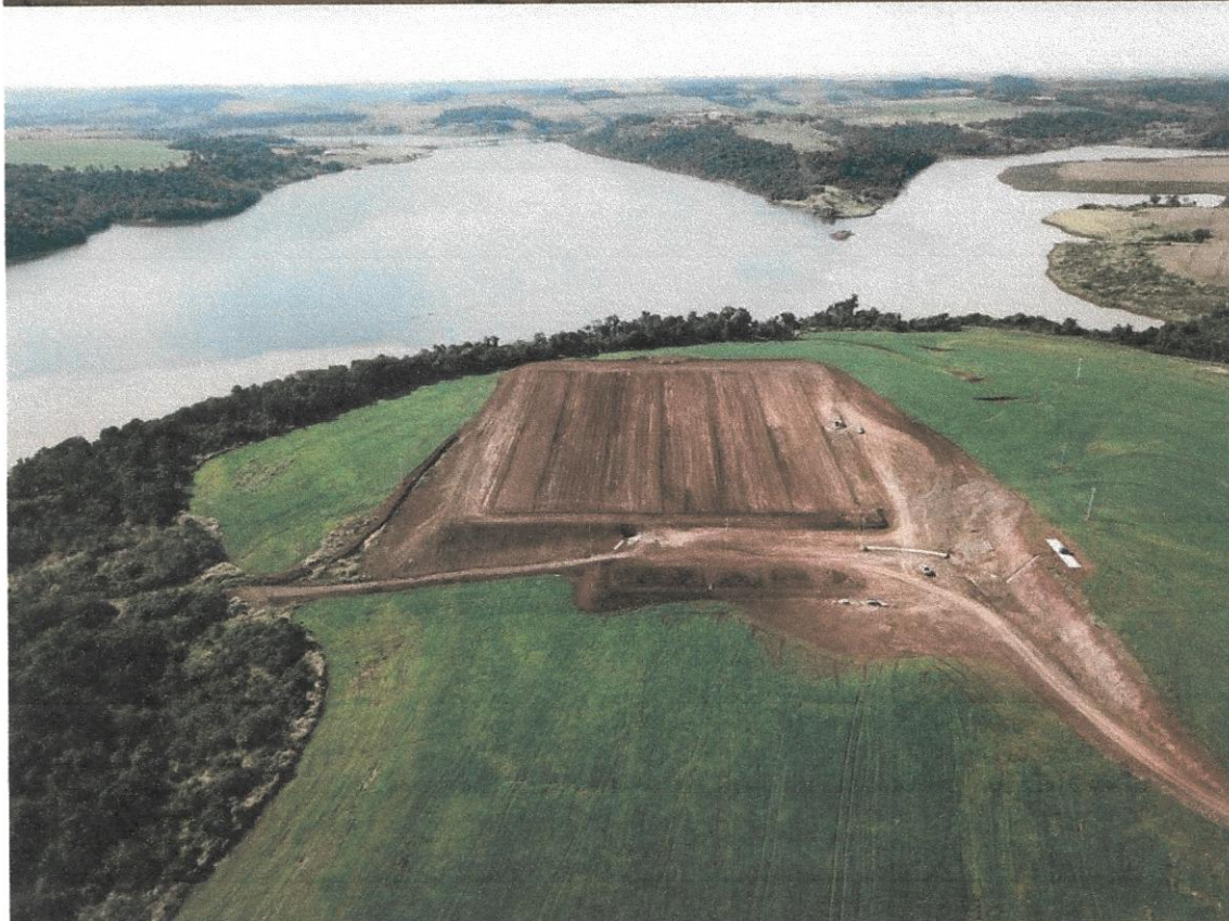
CANTEIRO DE OBRAS GRANJA FARADAY - CAPANEMA
