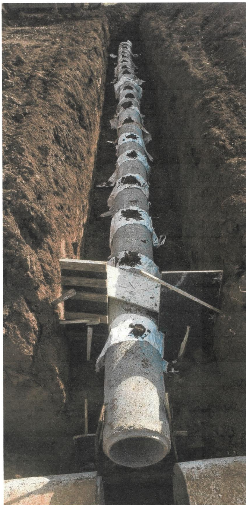
EXECUÇÃO DE TUBULAÇÃO NA GRANJA FARADAY - CAPANEMA
