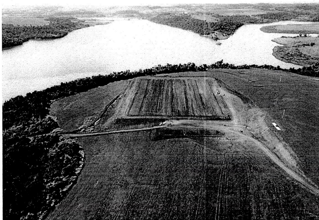
CANTEIRO DE OBRAS GRANJA FARADAY NÚCLEO 1 - CAPANEMA
