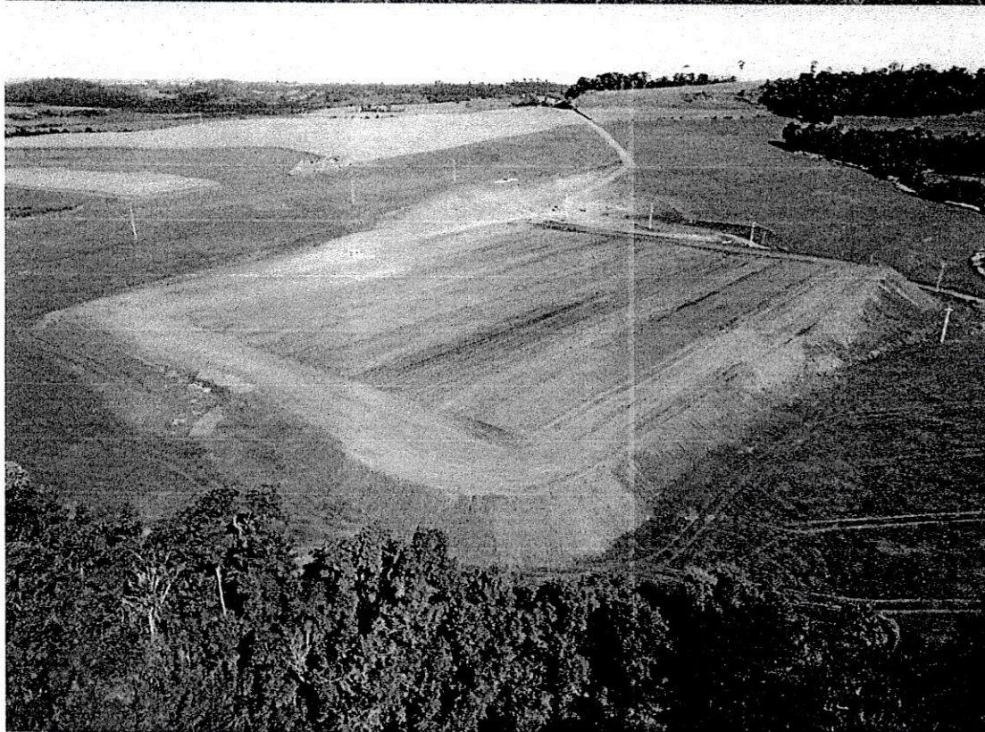
CANTEIRO DE OBRAS GRANJA FARADAY NÚCLEO 1 – CAPANEMA
